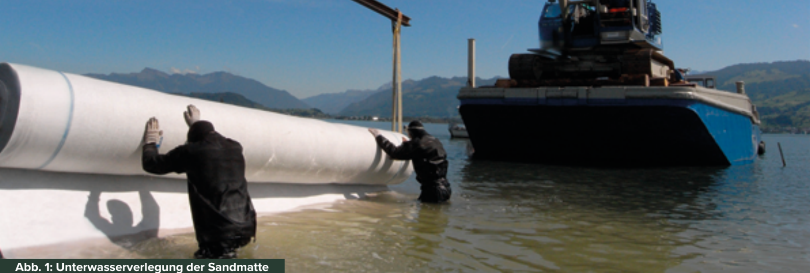
Abb. 1: Unterwasserverlegung der Sandmatte
