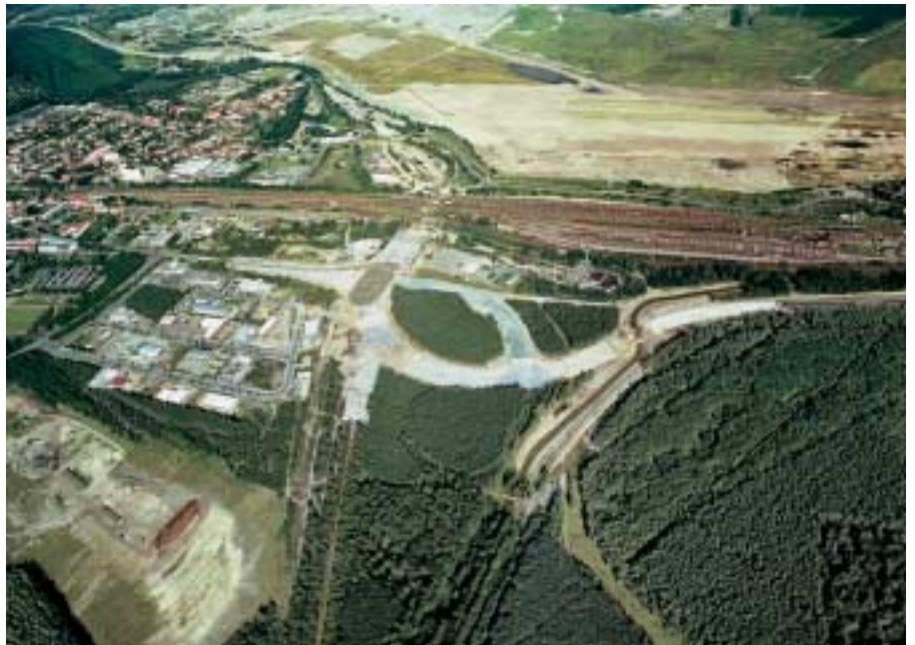
Panoramaaufnahme östlicher Knotenpunkt, Blickrichtung Südost
