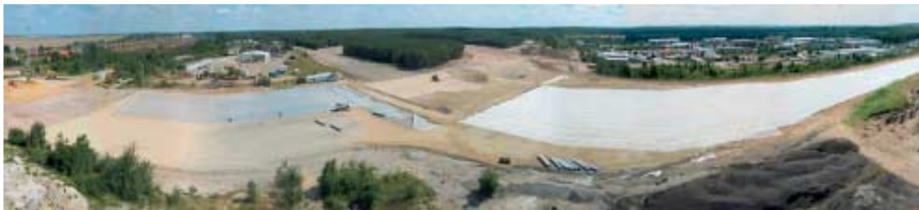
4 Panoramaaufnahme östlicher Knotenpunkt, Blickrichtung Südost
