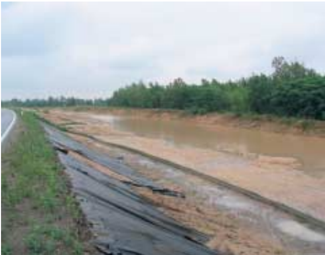
2 Neue Trasse im Kippengelände
