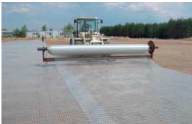
5 u. 6 Verlegung von Secugrid Geogittern
