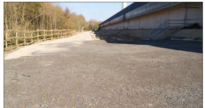
Abb. 2: Fertiggestellte temporäre Baustraße
