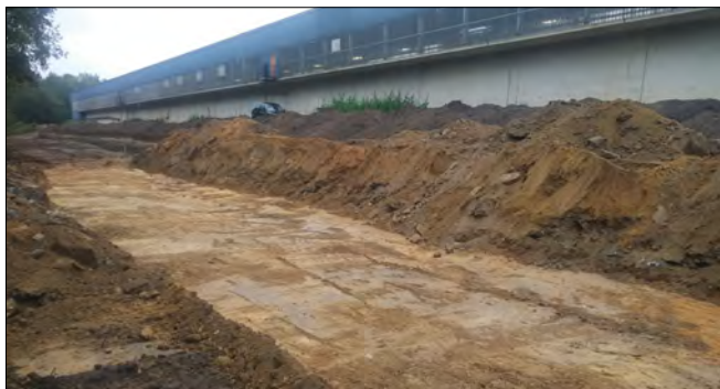
Abb. 1: Vorbereitetes Planum für den Aufbau einer temporären Straße
