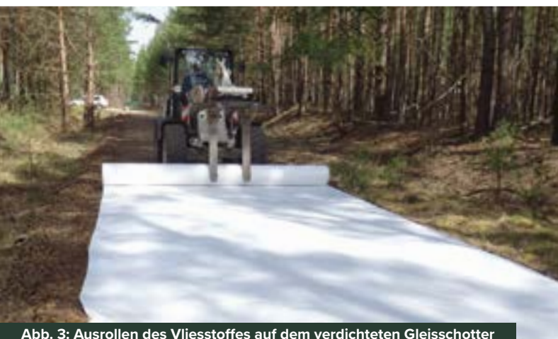
Abb. 3: Ausrollen des Vliesstoffes auf dem verdichteten Gleisschotter
