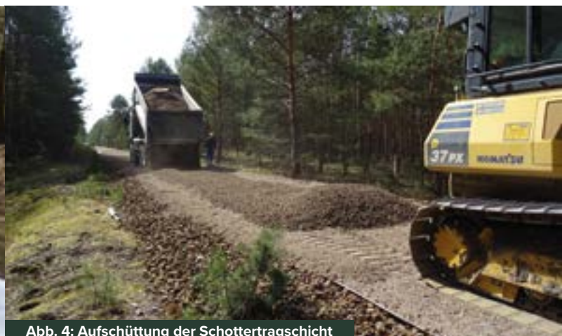
Abb. 4: Aufschüttung der Schottertragschicht
