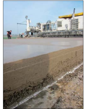
Abbildung 2: Einsatz im Betonstraßenbau
