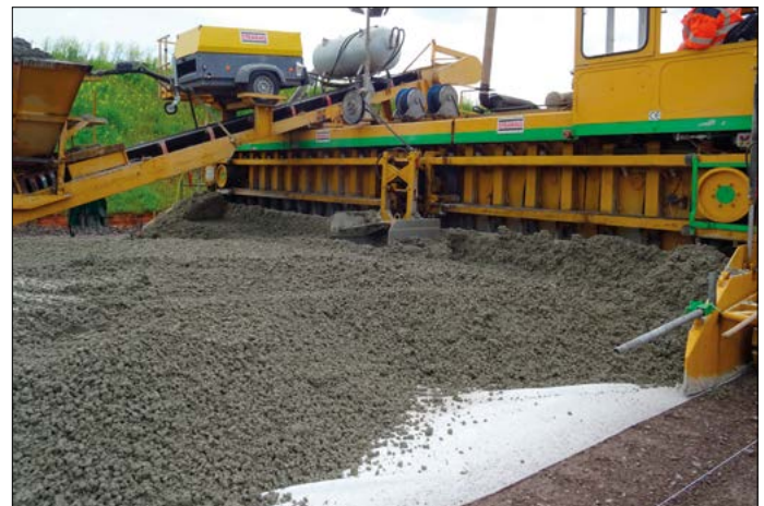
Abbildung 6: Einbau des Fahrbahnbetons mittels Betonfertiger direkt auf dem Betonvliesstoff
