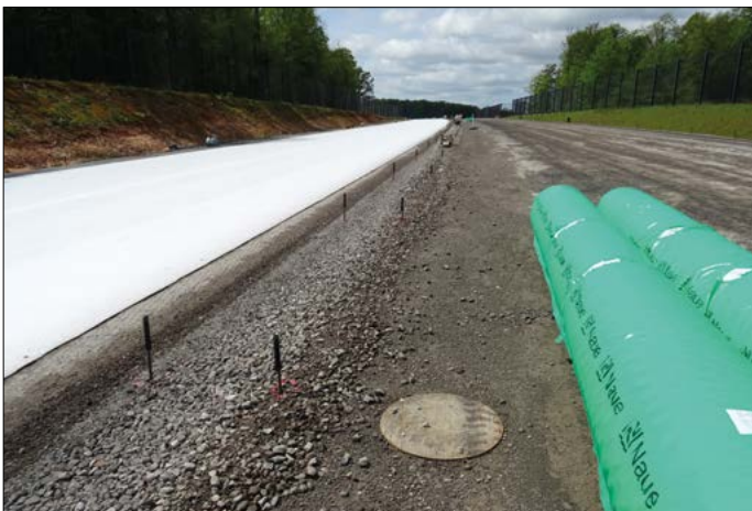
Abbildung 5: Secutex® R 501 auf hydraulisch gebundener Tragschicht (HGT) vor Betonage
