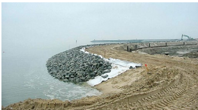
Abbildung 4: Deckwerksbau mit Secutex® H
