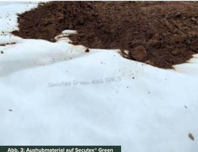
Abb. 3: Aushubmaterial auf Secutex® Green
