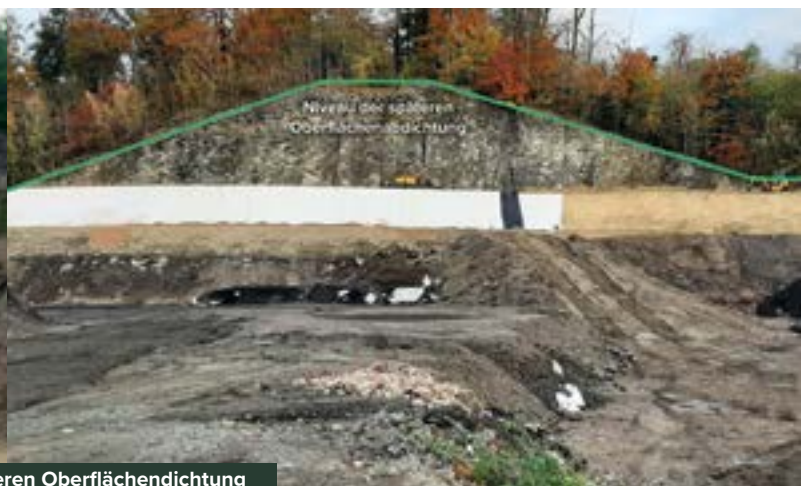
Abb. 3: Zustand vor Baubeginn und in der 6. Ausbaustufe mit Verlauf der späteren Oberflächendichtung
