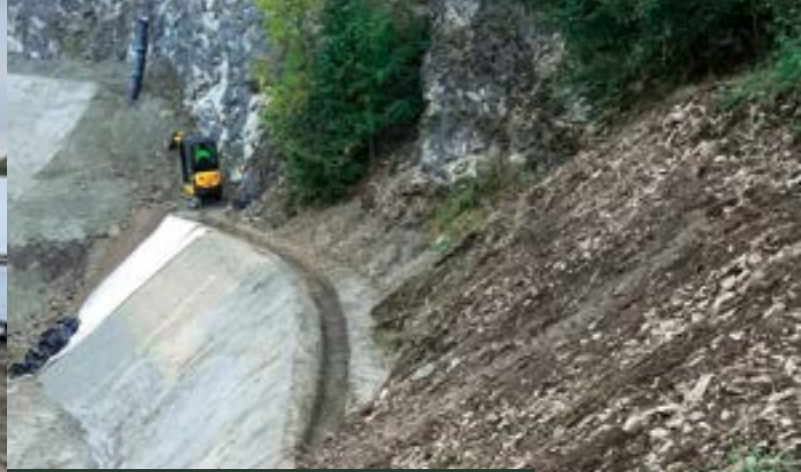
Abb. 2: Einbau Schutzvliesstoff an der Steilwand
