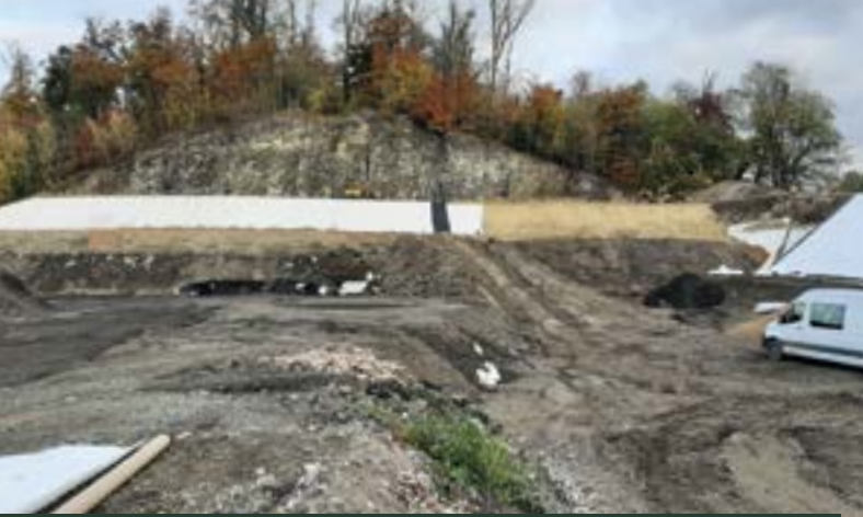
Abb. 1: Abdichtung der Steinbruchwand auf der Deponie Borgholzhausen
