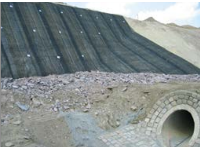
Abbildung 21: Steilböschung mit Wirrgelege
