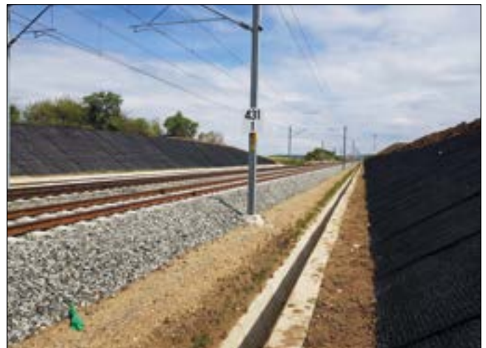
Abbildung 22: Bahndamm mit Wirrgelege
