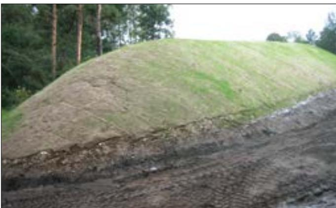
Abbildung 8: Jutenetz auf einer Böschung
