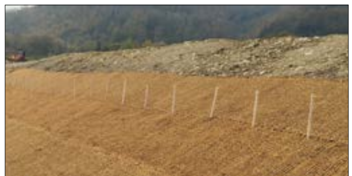
Abbildung 5: Einbau des Erosionsschutzsystems
