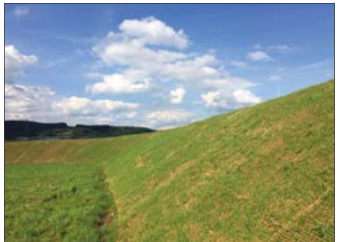
Abbildung 9: Kokosnetz auf der Böschung
