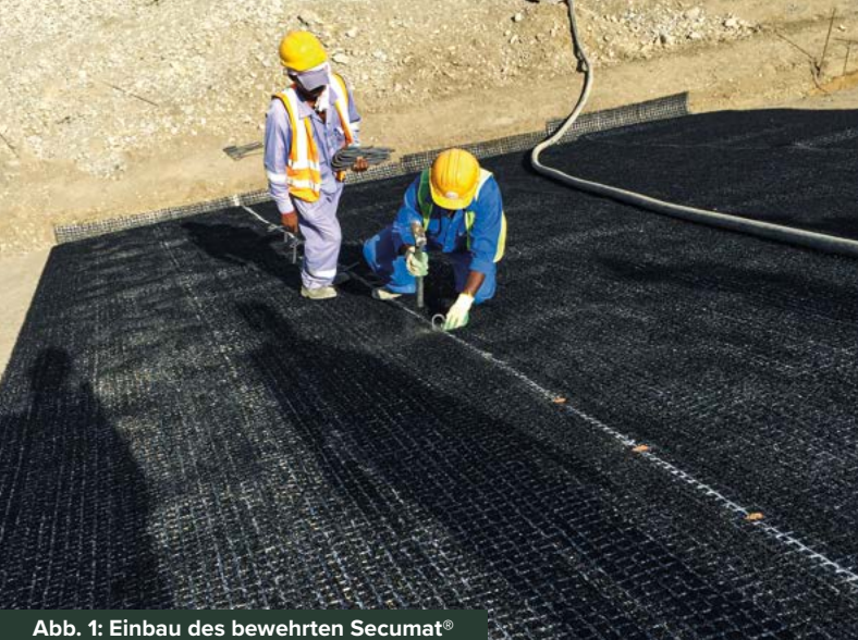
Abb. 1: Einbau des bewehrten Secumat®
