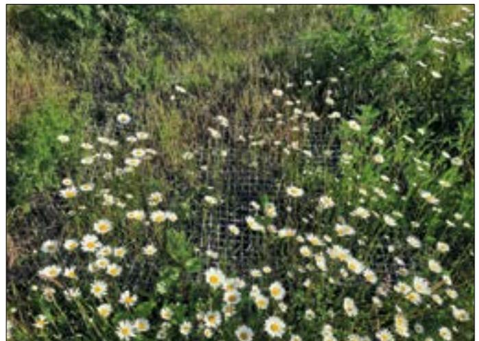
Abbildung 9: Bewachsenes Erosionsschutzsystem
