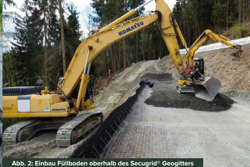
Abb. 2: Einbau Füllboden oberhalb des Secugrid® Geogitters
