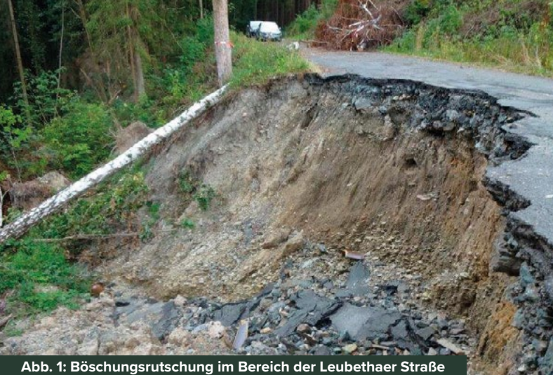
Abb. 1: Böschungsruhrung im Bereich der Leubethaer Straße
