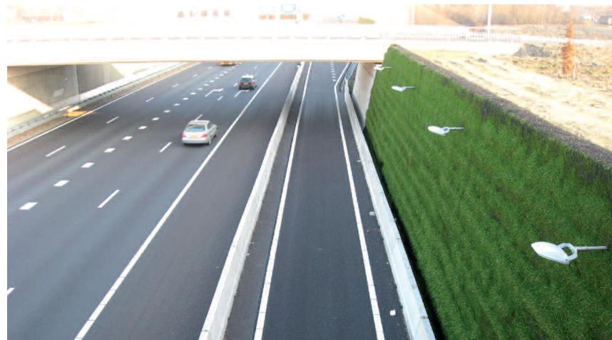
Die Systembewehrung Secugrid® PET wird nach bodenspezifischen Eigenschaften und statischen Erfordernissen nach DIN 1054:2005, DIN 4084 und EBGeo bemessen.
