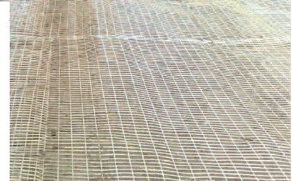
stabiles Geogitter für Bodenbewehrungsanwendungen entsteht. Typische Anwendungen für Secu-grid® Geogitter sind: Tragschichtbewehrungen, bewehrte Böschungen, bewehrte Stützkonstruktionen, Böschungssicherung, Gründungen von Erdämmen, Sicherung über Erdfallgebieten oder Überbauung von weichen Untergründen.
