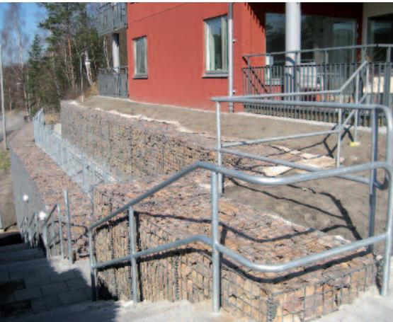
Die Systembewehrung SecuGrid® PET wird nach bodenspezifischen Eigenschaften und statischen Erfordernissen nach DIN 1054:2005, DIN 4084 und EBGE bemessen.
