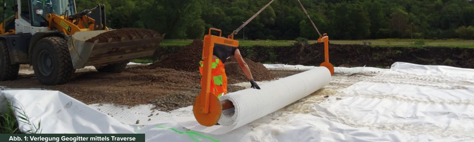
Abb. 1: Verlegung Geogitter mittels Traverse
