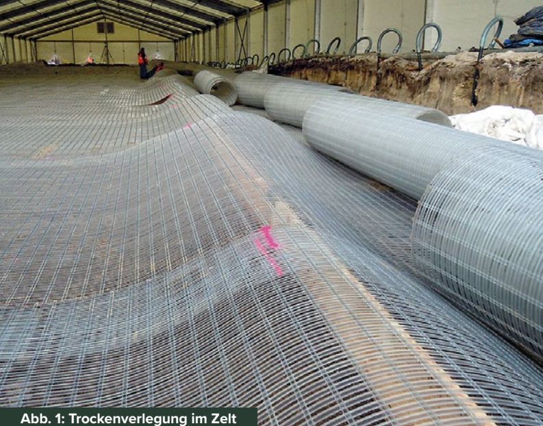
Abb. 1: Trockenverlegung im Zelt
