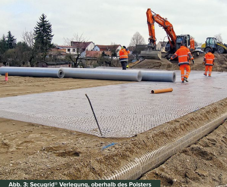
Abb. 3: Secugrid® Verlegung, oberhalb des Polsters
