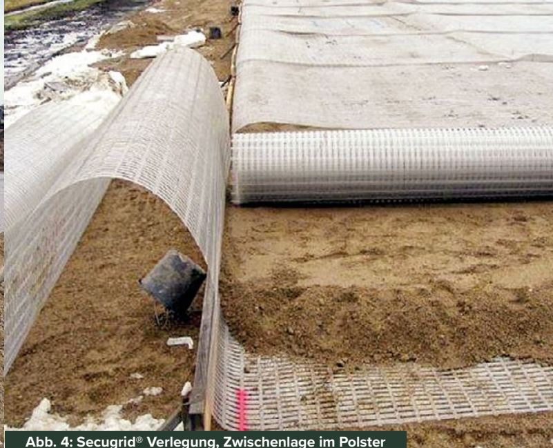
Abb. 4: Secugrid® Verlegung, Zwischenlage im Polster
