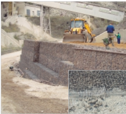
Frontansicht der Secugrid® bewehrten Rampenauffahrt
