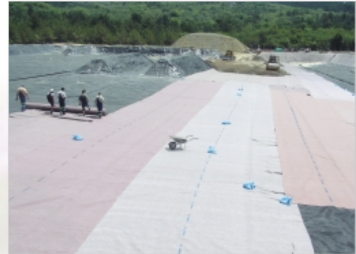
Secutex® Verlegung auf der Dichtung mit Carbofol® sowie Einbringung der mineralischen Dränschicht
