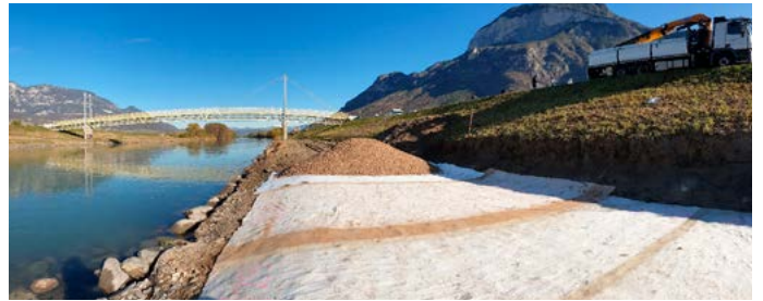
Uferbereiche von Gewässern sind ständiger geometrischer Veränderung unterworfen, wenn man natürliche Prozesse zulässt. Gut, wenn sich die eingebauten Bauprodukte wie die Naue GreenLine daran anpassen.
