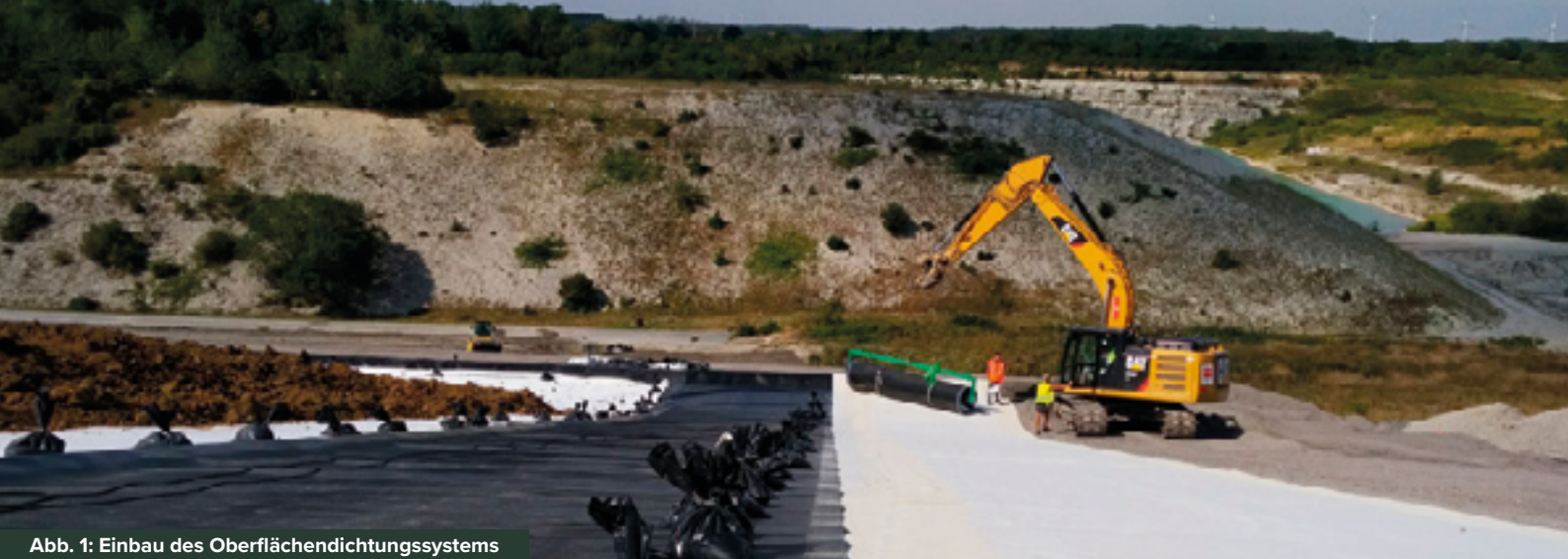
Abb. 1: Einbau des Oberflächendichtungsystems
