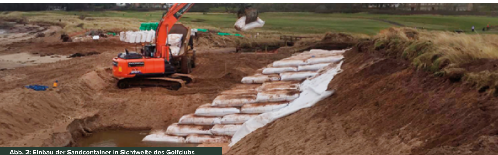
Abb. 2: Einbau der Sandcontainer in Sichtweite des Golfclubs
