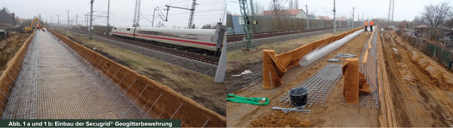
Abb. 1 a und 1 b: Einbau der Secugrid® Geogitterbewehrung
