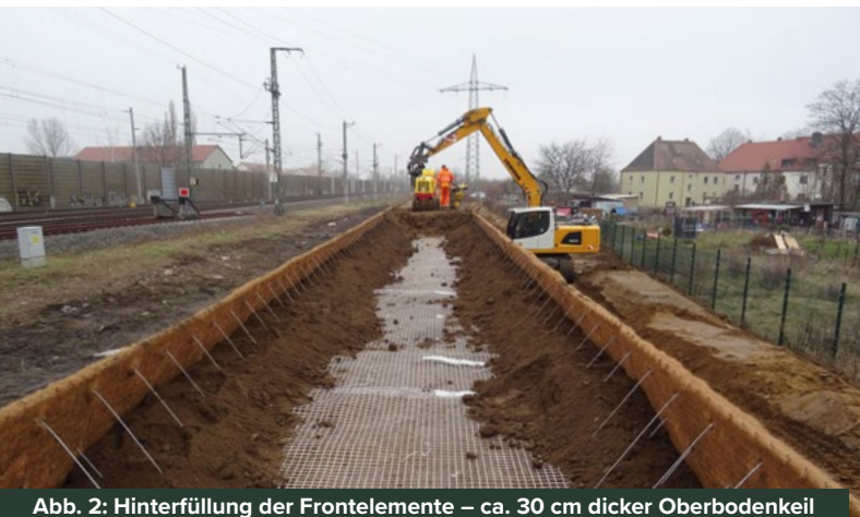
Abb. 2: Hinterfüllung der Frontelemente – ca. 30 cm dicker Oberbodenkeil
