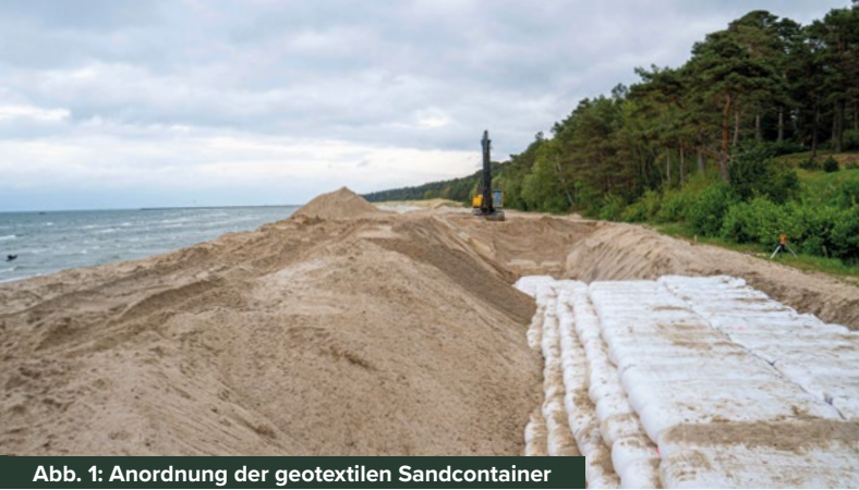
Abb. 1: Anordnung der geotextilen Sandcontainer
