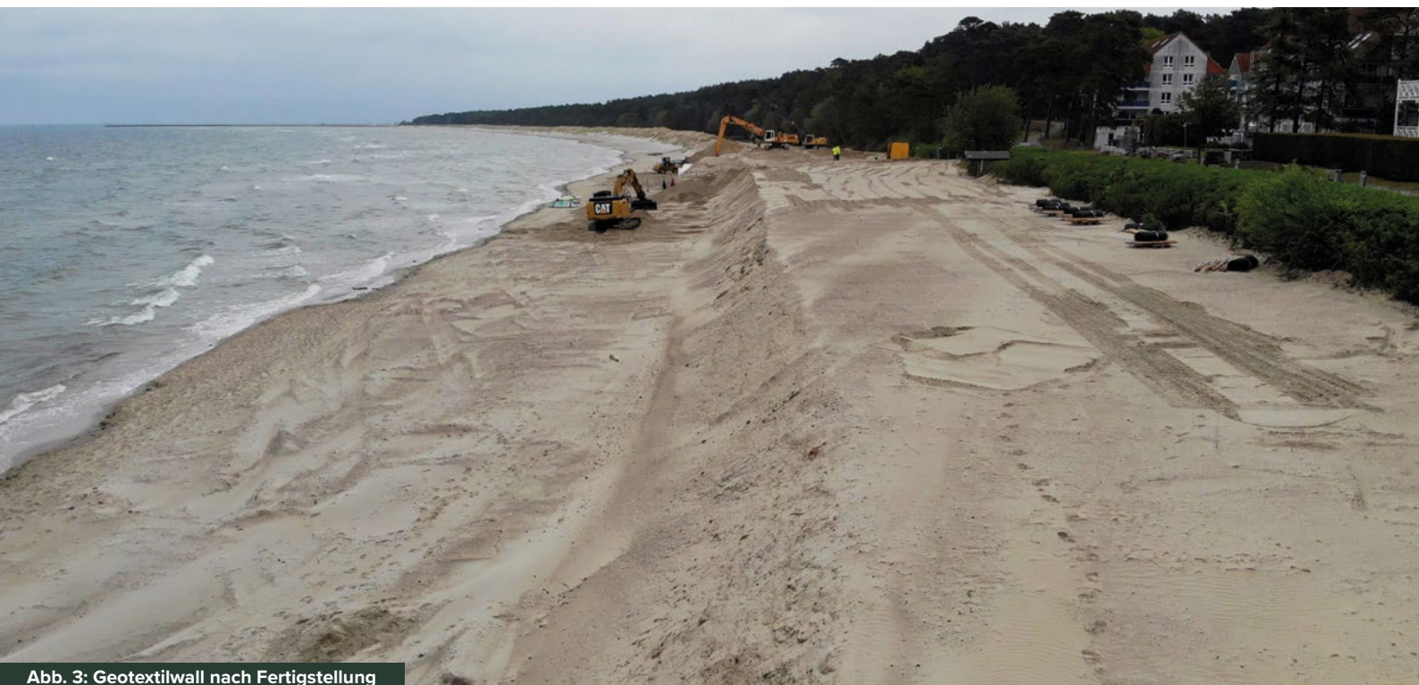
Abb. 3: Geotextilwall nach Fertigstellung
