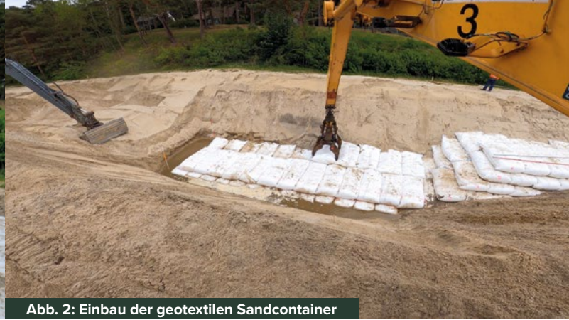
Abb. 2: Einbau der geotextilen Sandcontainer
