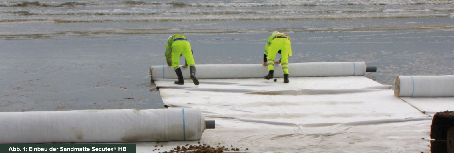
Abb. 1: Einbau der Sandmatte Secutex® HB
