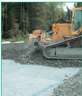
Bild 3 Secugrid® als Tragschichtbewehrung beim Bauvorhaben BAB A7, Füssen
