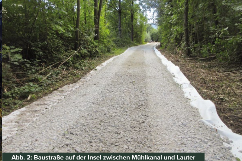
Abb. 2: Baustraße auf der Insel zwischen Mühlkanal und Lauter
