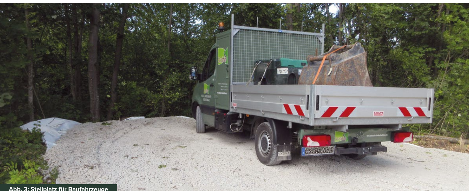
Abb. 3: Stellplatz für Baufahrzeuge
