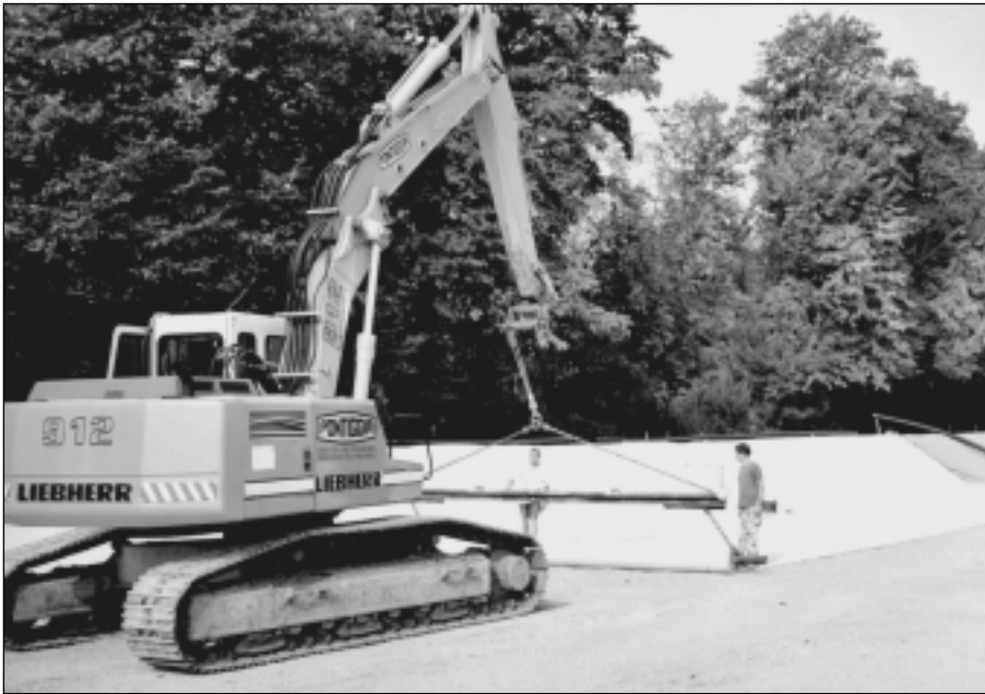
Abbildung 4: Verlegung der vernadelten geosynthetisch en Ton- dichtung als RiStWag- Abdichtung beim Bauvorhaben B 3 Wasser bei Freiburg
