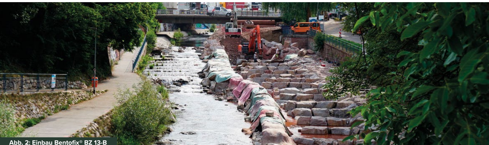
Abb. 2: Einbau Bentofix® BZ 13-B
