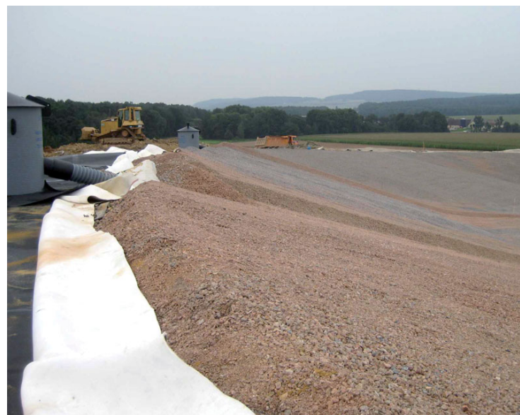
Bild 3 Fertiggestellter Randbereich der Zwischenabdichtung zum Altbereich
