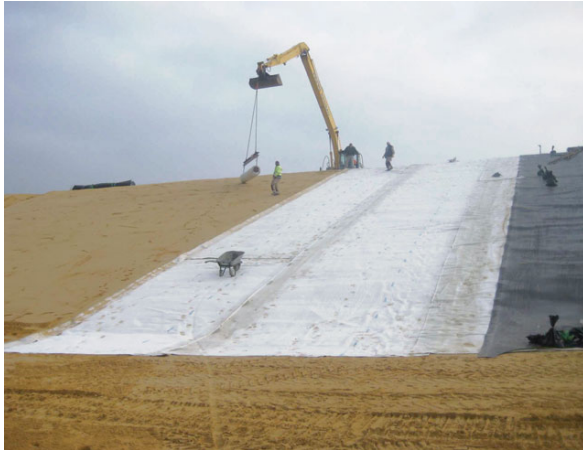
Bild 1 Überlappungsbereich mit geosynthetischer Tondichtungsbahn Bentofix® NSP 4900 LAGA
