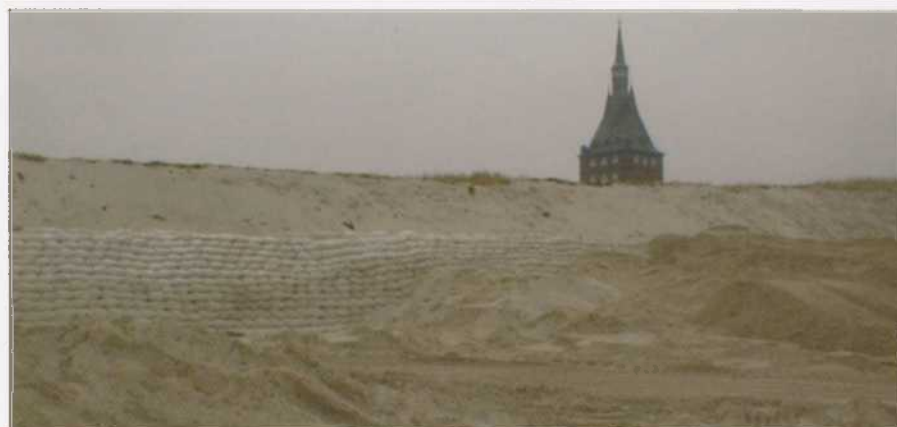
Abb. 4: Fortschreitender Aufbau der Dünenbarriere mit Sandsäcken am Westturm
