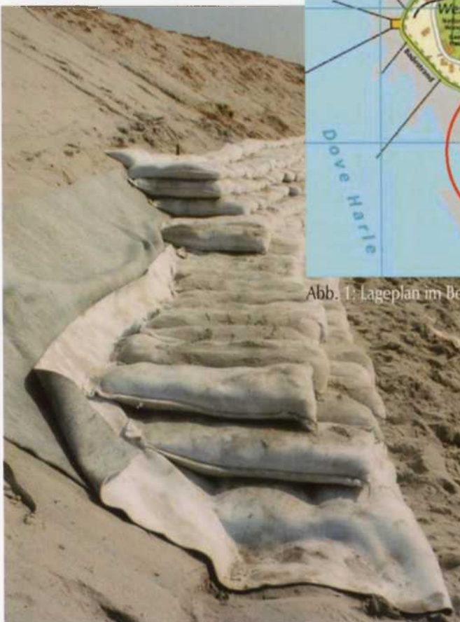
Abb. 2: Stabilisierung der Düne mit Sandsäcken, gestapelt auf einem um die erste Lage zurückgeschlagenen Filtergeotextil
