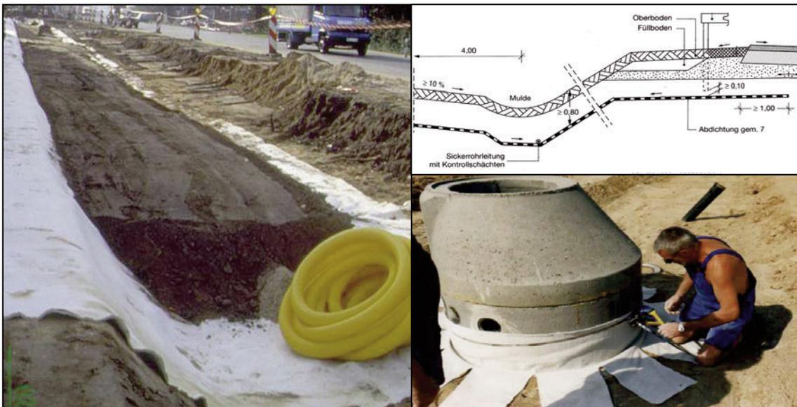
**Bild 3** Ausführung von Abdichtungsarbeiten mit GTD nach RiStWag
