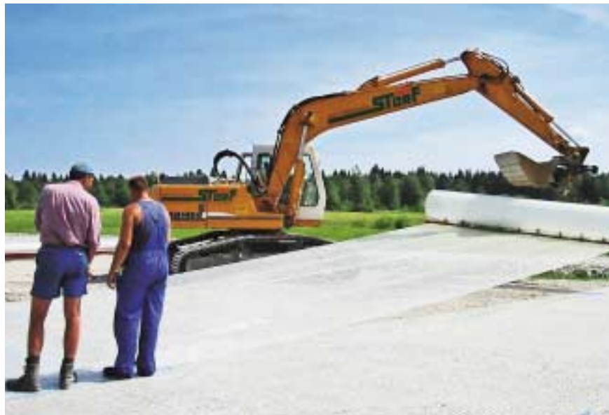
6 Verlegung von Secugrid®
