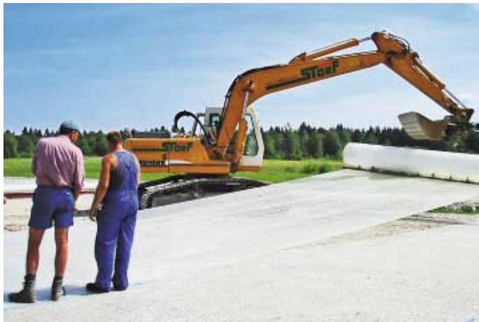
Verlegung von Secugrid®
