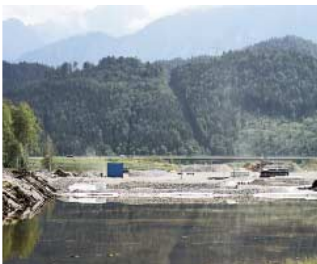
1 Mit der Ausführung der Vorschüttung im Bereich des AS Füssen bis zur Bundesgrenze (Los 1) wurde begonnen, den Lückenschluss auf der BAB 7 zwischen Nesselwang und Füssen zu schließen
