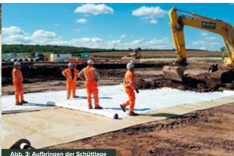
Abb. 3: Aufbringen der Schüttlage
