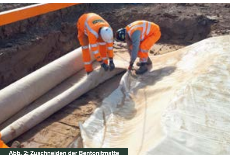
Abb. 2: Zuschneiden der Bentonitmatte
