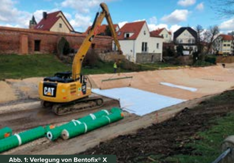
Abb. 1: Verlegung von Bentofix® X
