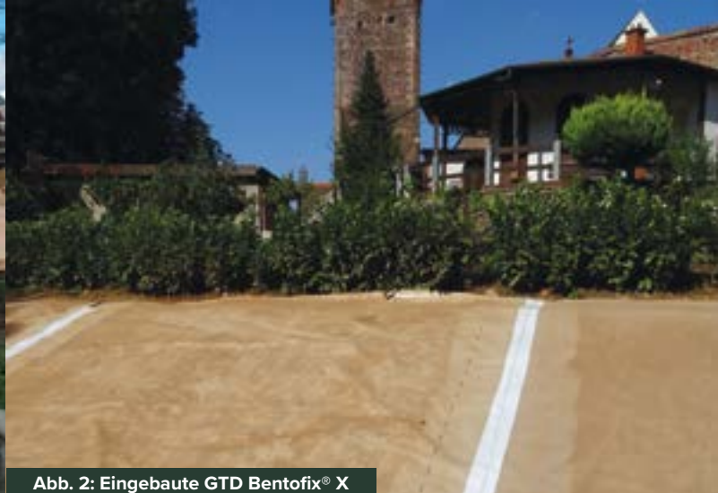
Abb. 2: Eingebaute GTD Bentofix® X
