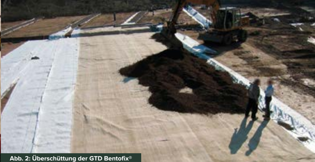
Abb. 2: Überschüttung der GTD Bentofix®
