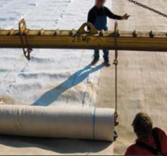
Abb. 1: Verlegung von Bentofix® mittels Traverse
