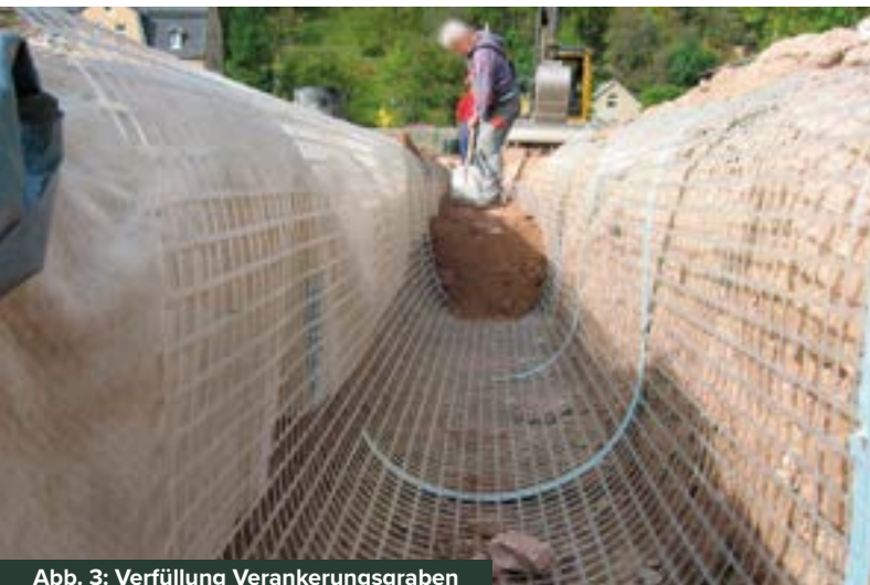
Abb. 3: Verfüllung Verankerungsgraben
