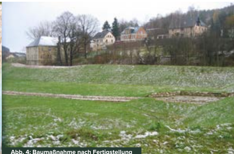
Abb. 4: Baumaßnahme nach Fertigstellung
