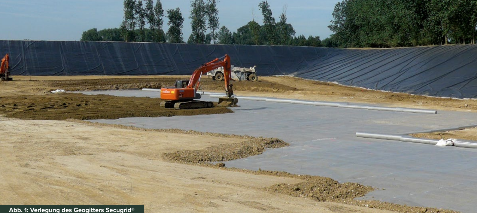
Abb. 1: Verlegung des Geogitters Secugrid®
