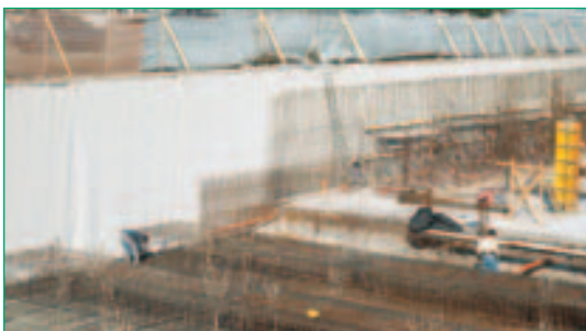
Einbringung der Stahlbewehrung vor Bentofix®
