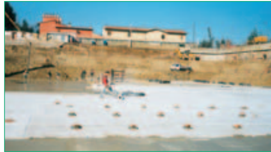
Verlegung der Bentofix® Bauwerksabdichtung und Aufbringung einer Magerbetonschicht
