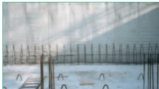
Senkrechte Befestigung von Bentofix® gegen eine Betonwand
