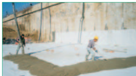
Betonaufbringung über Bentofix®
