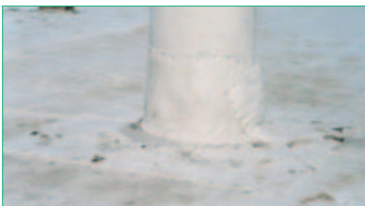
Abgedichtete Durchdringung mit Bentofix®
