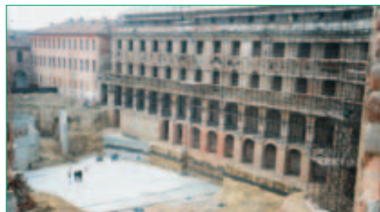
Baumaßnahme mit Bentofix® Bauwerksabdichtung
