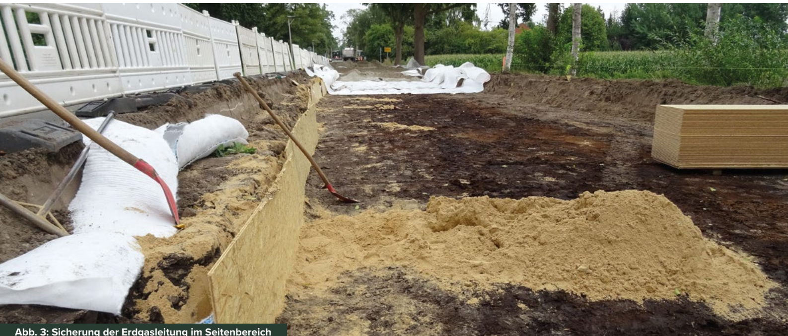
Abb. 3: Sicherung der Erdgasleitung im Seitenbereich
