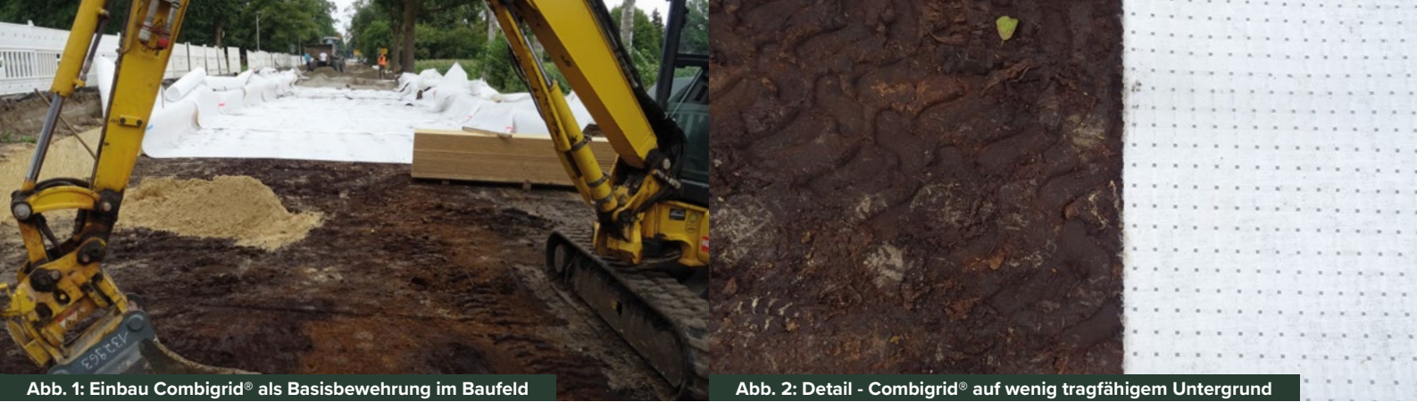
Abb. 1: Einbau Combigrid® als Basisbewehrung im Baufeld
